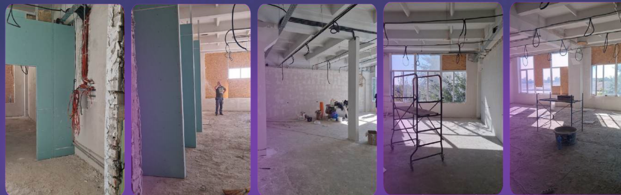
Локація 3. Напрямок: електромонтажні роботи
